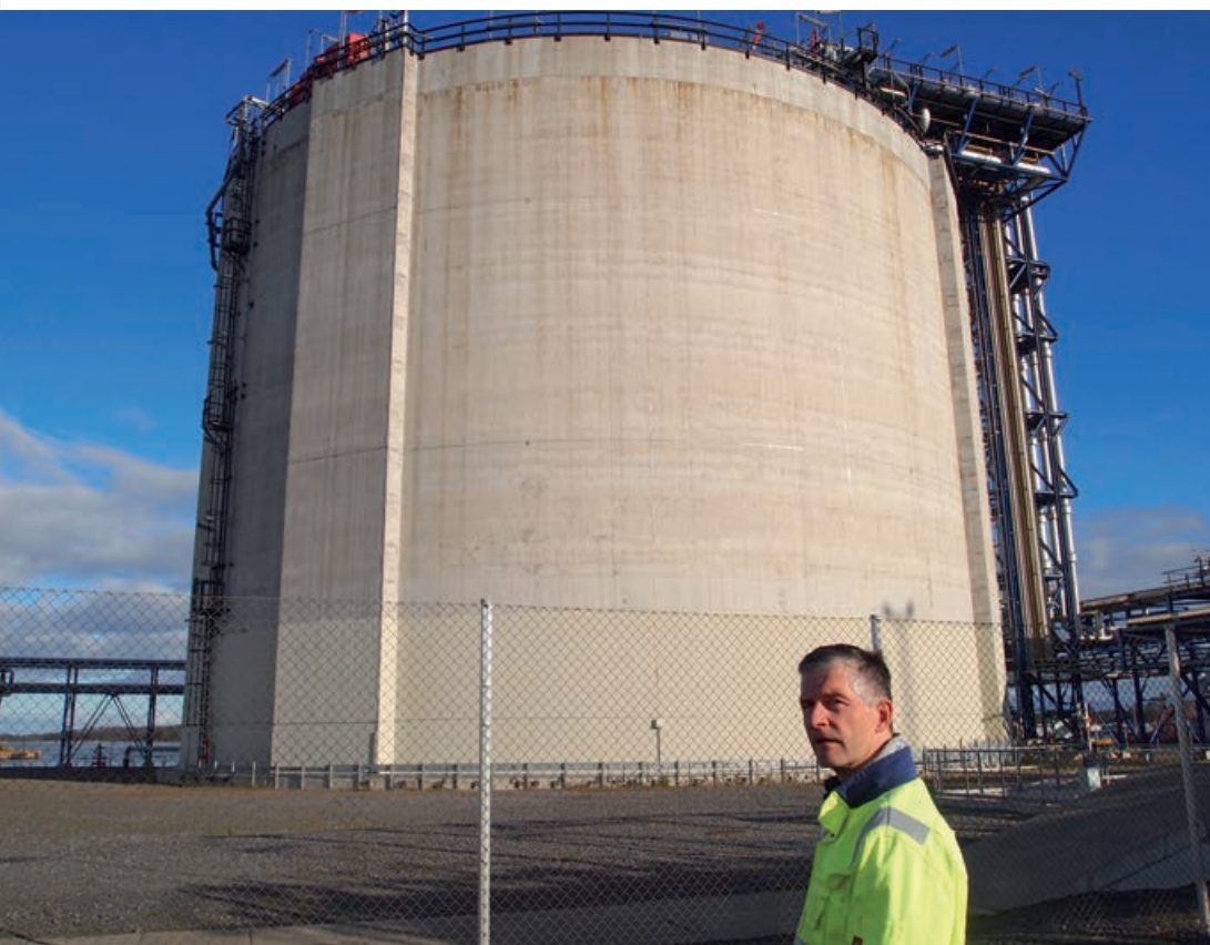
– Tahkoluodon LNG:n varastointisäiliö on 35 metriä korkea, sen halkaisija on 42 metriä ja säilöön voi varastoida 30 000 m 3 :a eli 15 tonnia nesteytettyä maakaasua, terminaalipäällikkö Marko Toivonen sanoo.
