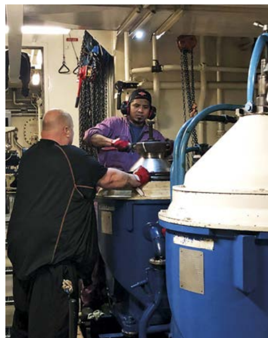
Korjausmies Timo Laakso ja 2. konemestari Jhun Cortes kunnostavat separaattoria.
