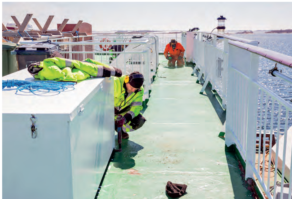
Ålandsrederiernas fraktfartyg seglar till stor del under bekvämlighetsflagg. Sjöfarten erbjuder ändå arbetsplatser också för ålänningar.
