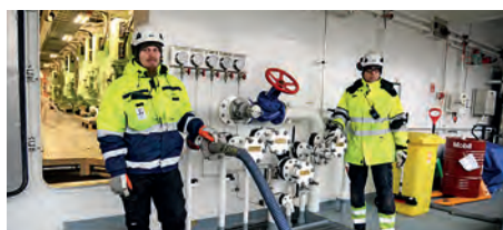
Yt-matruusi Jimmy Paananen ja yt-konekorjausmies Jussi Helminen laskevat Katajanokalla Polariksen pilssi- ja jäteöljyt tankkiauton kyytiin.
