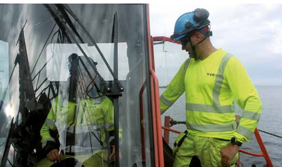
YIT:n Ajoksen työmaan työsuojeluvaltuutettu Antti Lönnfors korostaa valppauden merkitystä lauttatyössä. Kuvassa porarit Antti Lönnfors (kopissa) sekä Petri Vesämäki.
