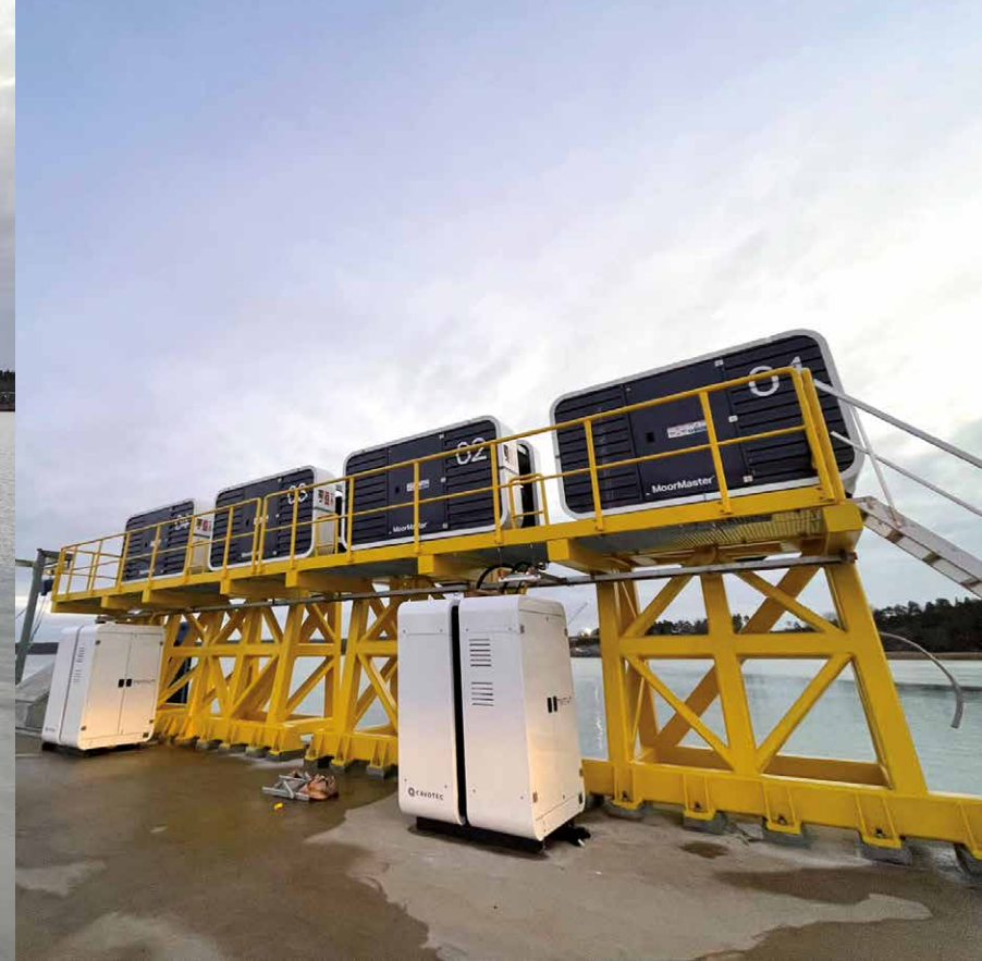
Finnlinesin uudet Superstar ropax-laivat kiinnittyvät laituriin "automuuringilla", eli imukupeilla. Aluksen ollessa satamassa käytetään maasähköä, mikä lisää vihreää siirtymää
